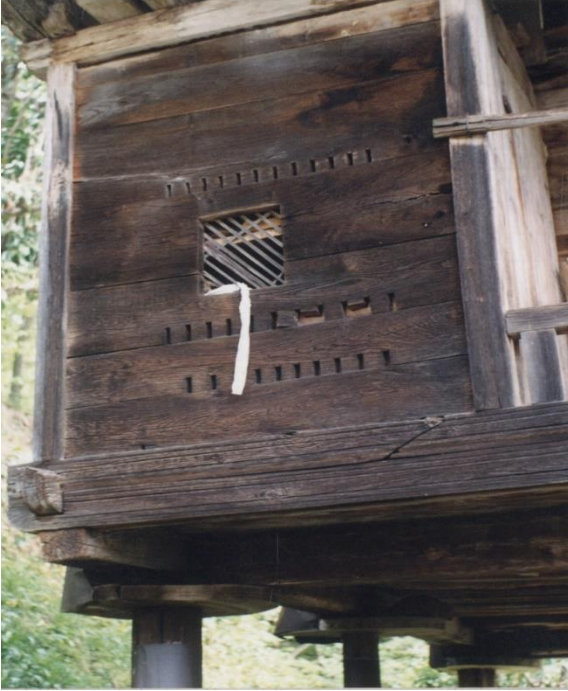
Res.5 Ambar sol taraf ve duvarda küçük havalandırma düzenlemeleri, (01.05.1996).
