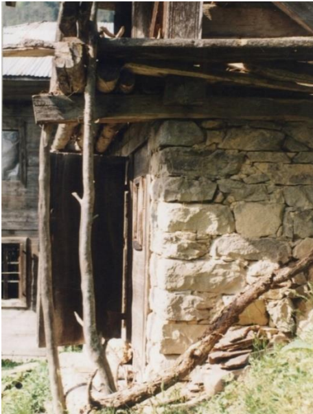
Res. 3 Bodrum kat. Ön, sağ-yan görünüş ve doğal taş duvardan ayrıntı, (01.05.1996).
