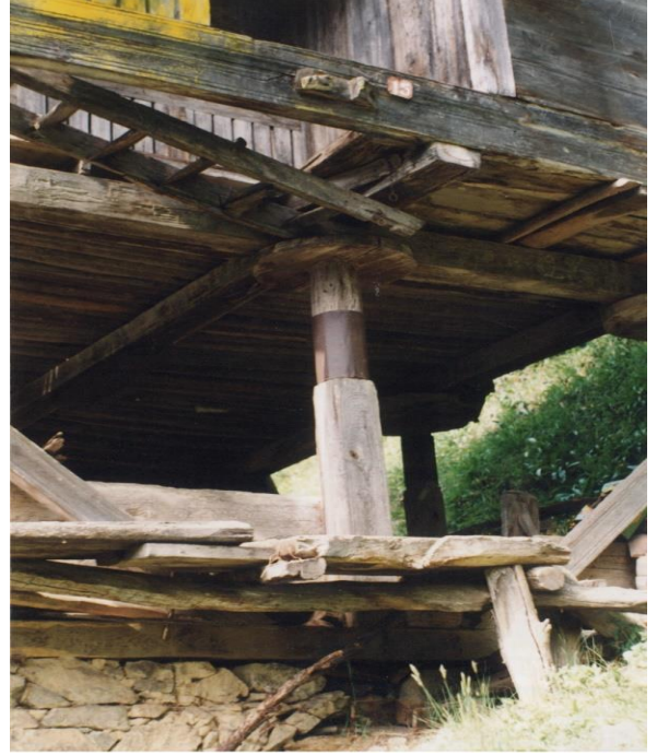
Res.6 Taşıyıcı sistemden ayrıntı ve üstteki ambar katında balkon, (01.05.1996)
