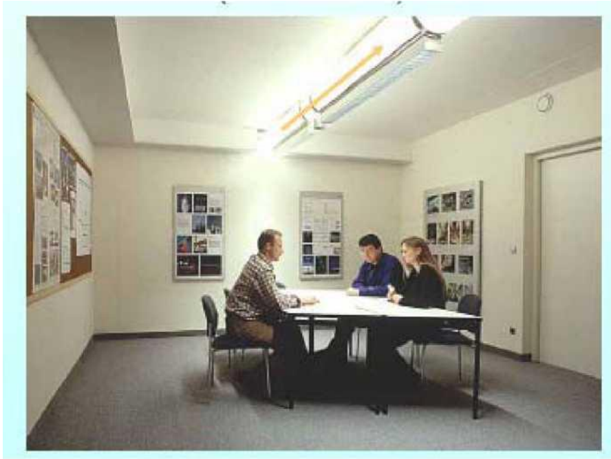
Şekil 9. Akıllı Aydınlatma Kılavuzları İle Taşınan Gn Işıđının Eđitim Kurumu Binalarının İ Hacminde Kullanılması
